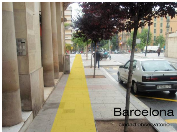
Fig. 6: Una calle cualquiera de Barcelona donde el espacio de la acera se ve reducida por cajas de instalaciones y alcorques sin cubrir
